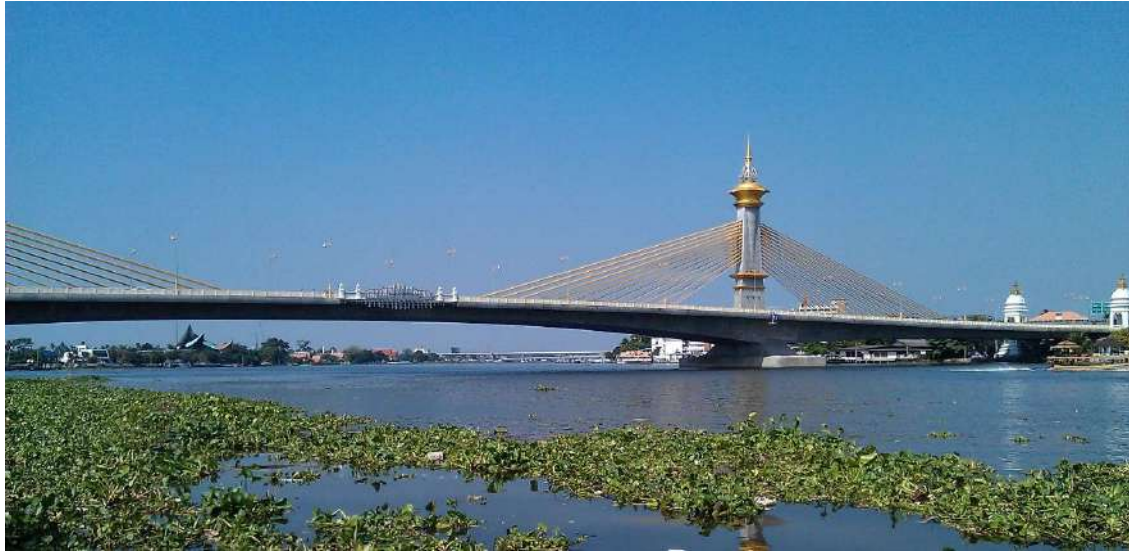
รูปที่ 7.2-2 ภาพตัวอย่างโครงสร้างสะพานคานซิง (Extradosed Bridge)
